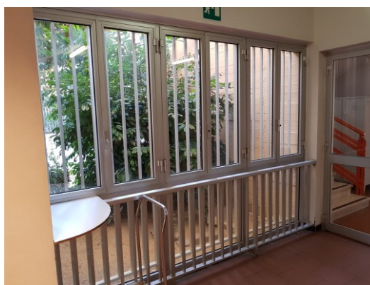
Figura 8.3 - Particolare dei serramenti esistenti
