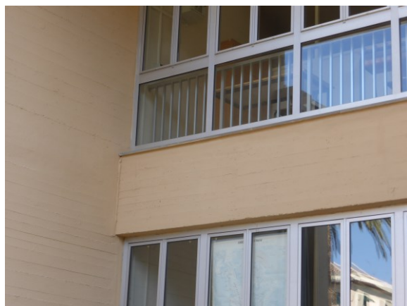
Figura 4.5 – Rilievo termografico dei serramenti tipo
