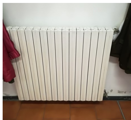
Figura 8.7 - Particolare dei radiatori esistenti
